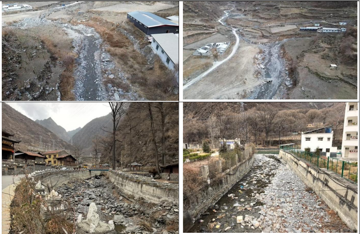
图 3-8 太平沟治理段现状
