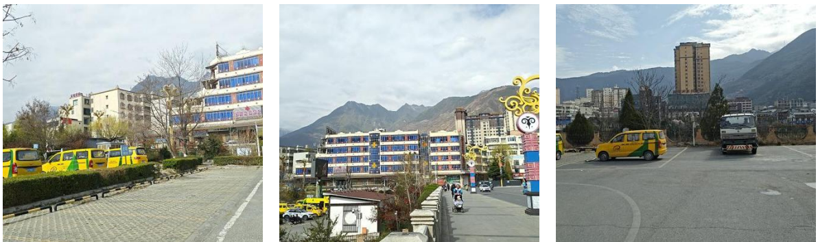
图 2-12 H03-01 地块建设情况现状照片
